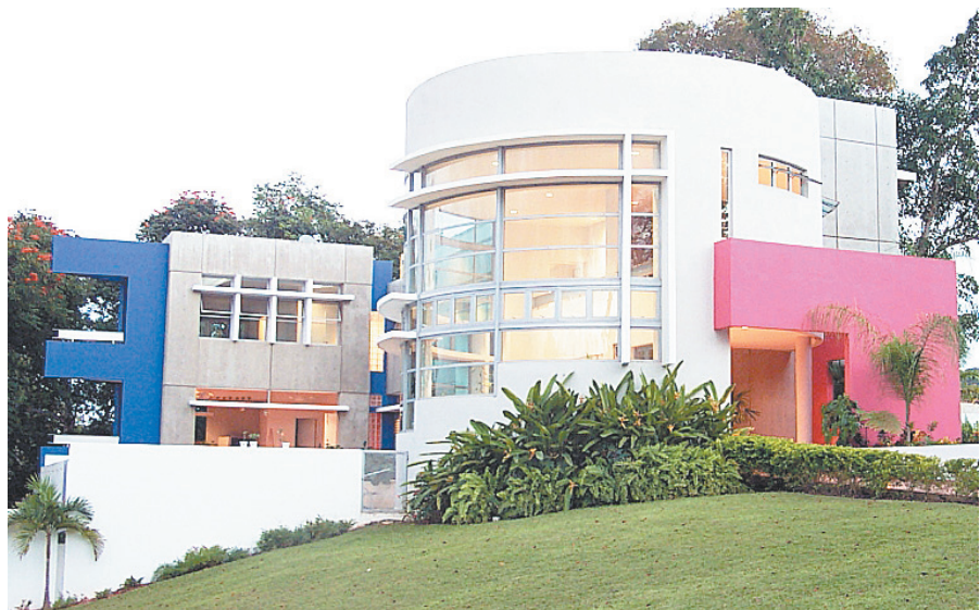
UN GRAN volumen cilíndrico alberga la sala a doble altura y su gran pared curva en cristal responde a las vistas escénicas a 180 grados que rodean la casa.
